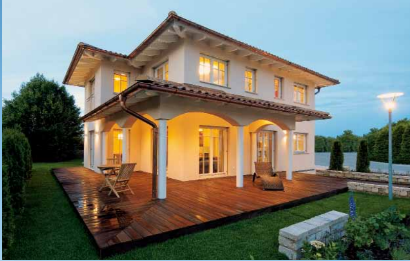
Eine große, über Eck laufende Echtholzterrasse mit Rundbögen und Säulen rundet das Bild der mediterranen Villa ab.
