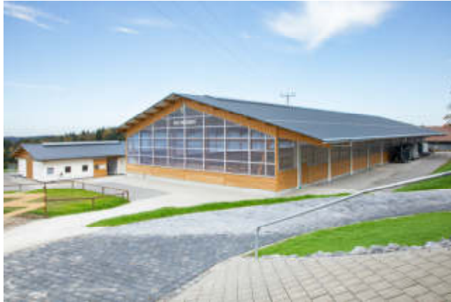
Bild 3d_ Geschäftsbereich Landwirtschaftsbau/Reitanlagen
