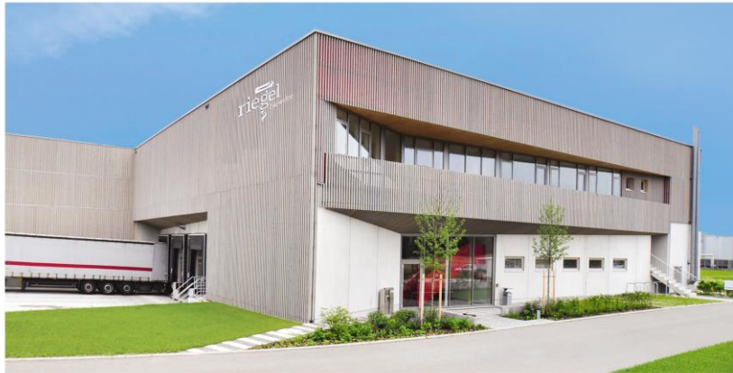
Bild 4: Der Bau von teil- und schlüsselfertigen Gewerbe- und Industrie-projekten in Holzfertig- und Hybridbauweise ist seit den 80er Jahren eine tragende Säule des Haas Geschäftsmodells.
